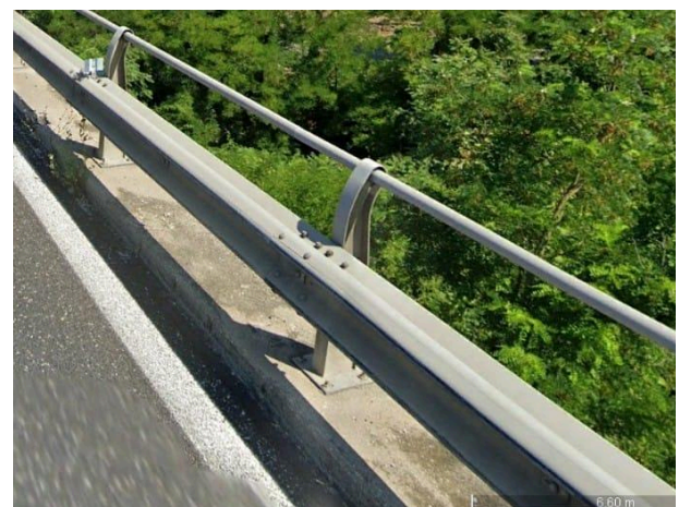
Particolare Guardrail Viadotto VOLUMNI
